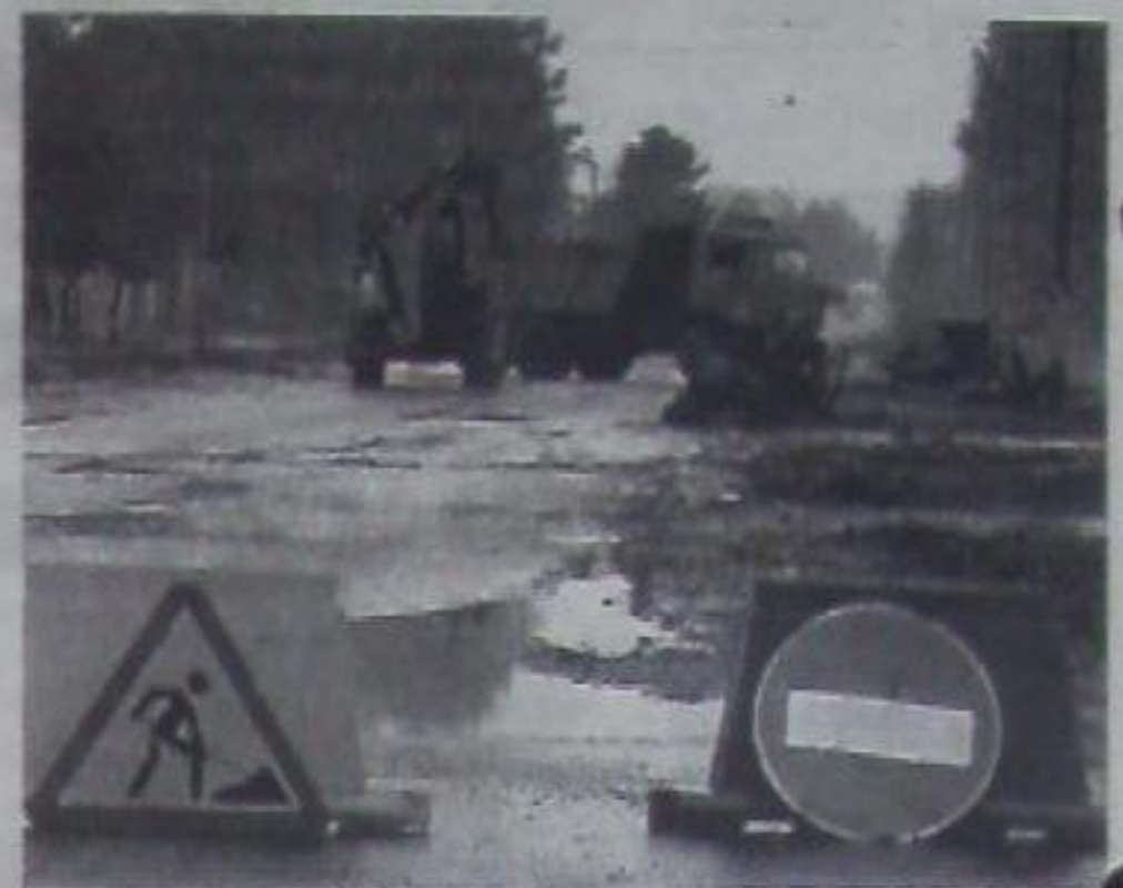
♦ кипит работа на ул. Красной г. Новопавловска.
