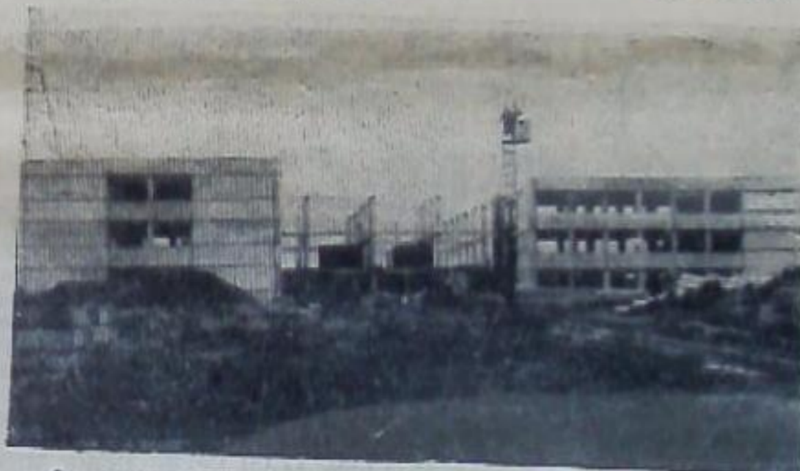
Строится городок энергетиков.
