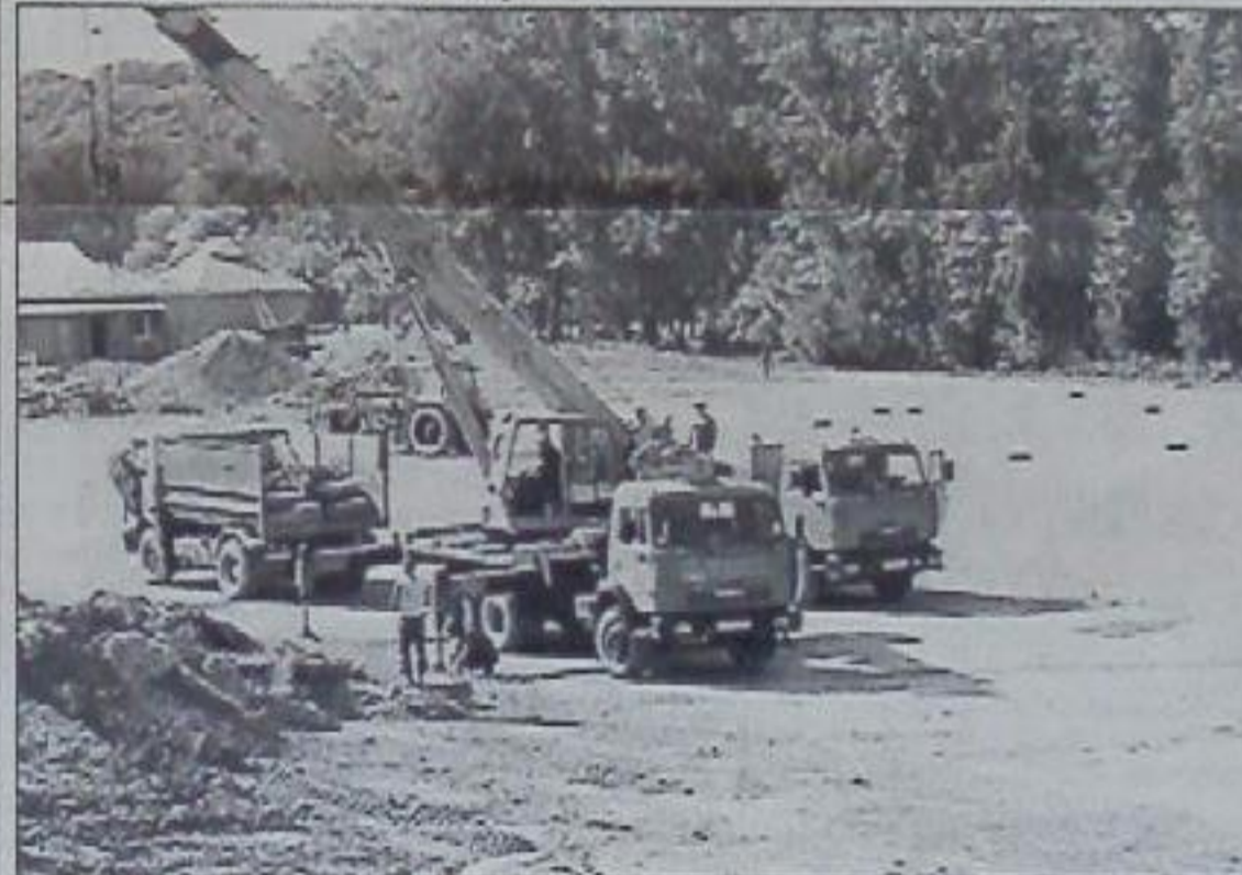
Особая же гордость всего коллектива строителей – выигранный в июле т.г. тендер на реконструкцию мотодрома в Новопавловске, на площадке которого развернулась нынче настоящая строительная баталия. Ведь сдать этот объект в эксплуатацию предстоит уже к ноябрю 2011 года. В том, что это будет одно из самых современных, красивых и удобных спортивных сооружений, сомнений нет.
