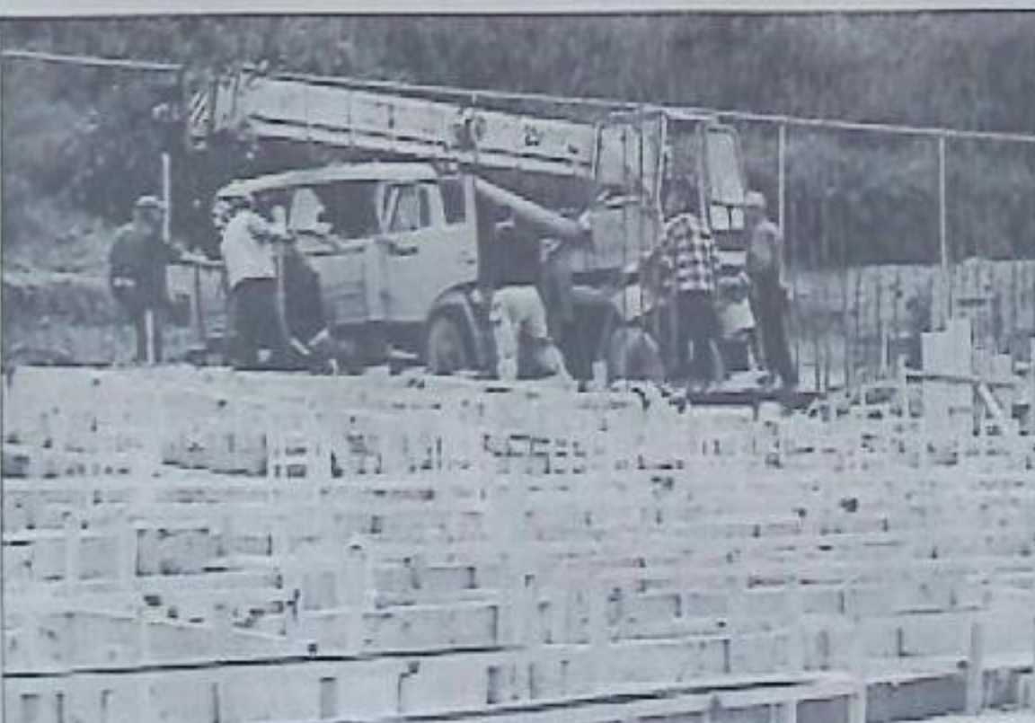
Бригада мастера строительного-монтажных работ Петра Сухова заливает фундамент центральной трибуны.
