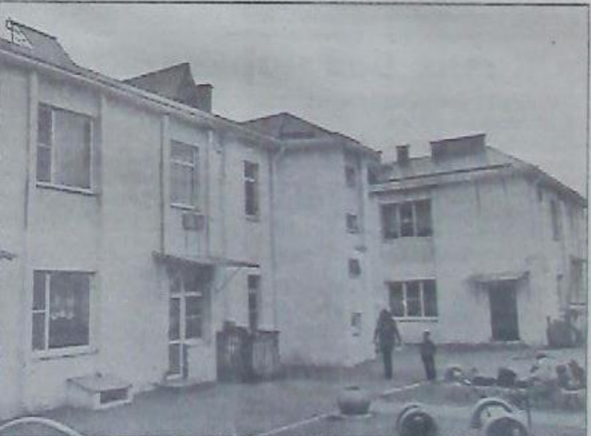
◆ А это детский сад имени атамана Г.А. Тутова. Здесь заменили кровлю, окна, отремонтировали систему отопления.
