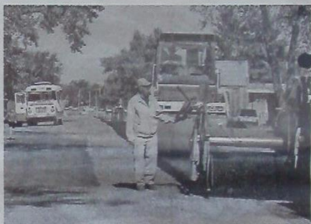
◆ Идёт ремонт дороги по улице Ставропольской.
