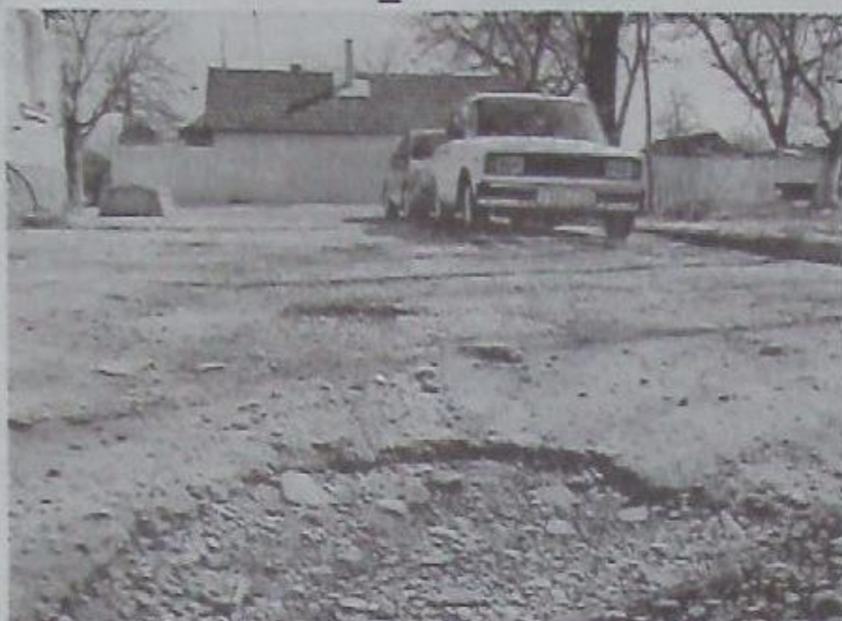
◆ Так выглядел двор пятиэтажки на улице Садовой г. Новопавловска до ремонта.
